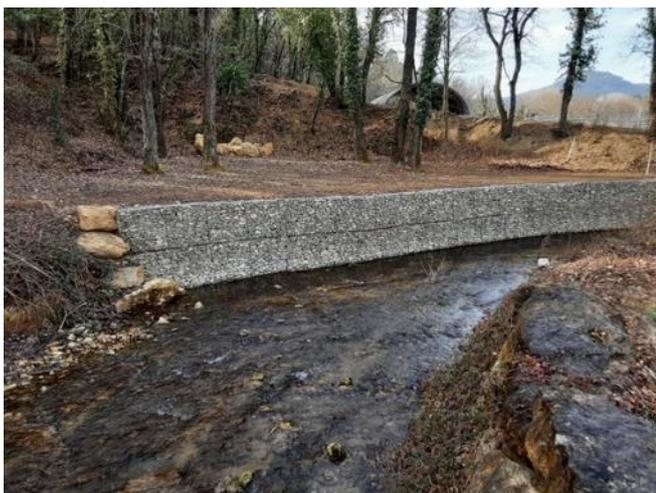
Illustration 77 : Ouvrage de protection en gabion recensé sur la rivière de Pelcourt
