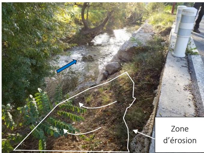
Illustration 48 : Zone d'érosion en rive droite de la Bresque, le long du chemin des Lômes – l'érosion menace la stabilité de l'enrochement
